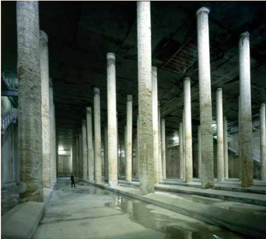
Dipòsit ubicat a Joan Miró, Barcelona. Font: BCASA
