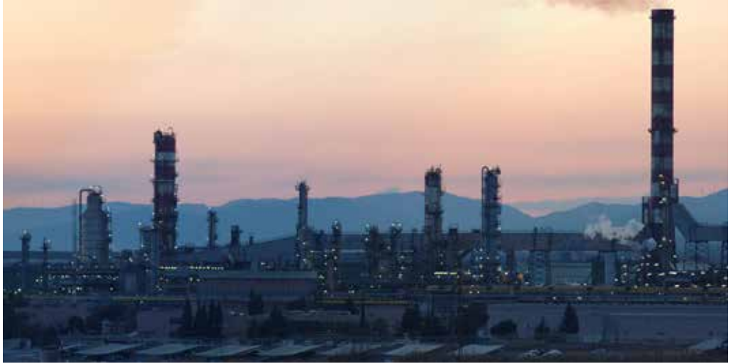
Figura 3: Fotografía del complejo petroquímico de Tarragona. Imagen: Jacob García.
