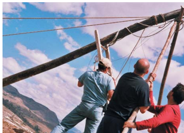
Voluntaris d'ESF i un membre de la comunitat d'Ahiadero aixequen un aerogenerador (Cajamarca, Perú)
