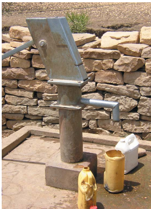
Bomba manual recíproca. Tipus Afridev o Indian Mark: esquema i exemple a Etiòpia
