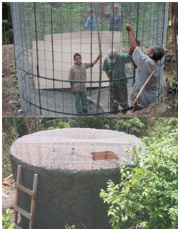
Construcció d'un tanc de ferrociment
